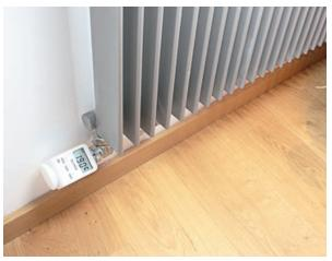
Das LUPUSEC Heizkörperthermostat ermöglicht die intelligente Steuerung Ihrer Heizung über die LUPUSEC Alarm Zentrale. Mit Hilfe von einfach zu erstellenden Zeitplänen regulieren Sie die Raumtemperatur und passen so die Heizphasen Ihren individuellen Bedürfnissen an.
